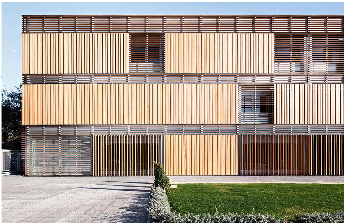
*Nel blocco ovest del Centre d'Idiomes de la Universitat de València dello studio di architettura Arkitera SLP la struttura della facciata è determinata dalla combinazione di lamelle fisse e mobili per la protezione solare.*
