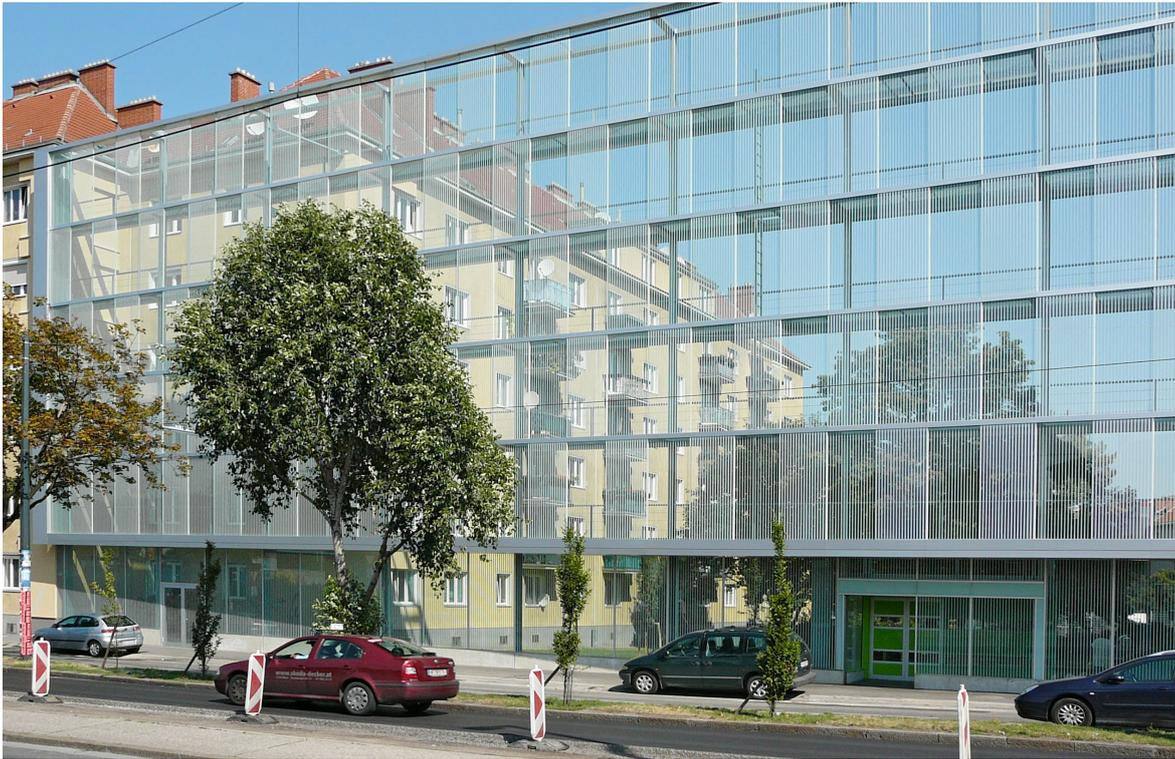
La struttura tridimensionale del riparo fonico della Treusch architecture presso il Theodor-Körner-Hof di Vienna viene volutamente rinforzata dal punto di vista visivo mediante marcature utilizzate per la protezione degli uccelli
