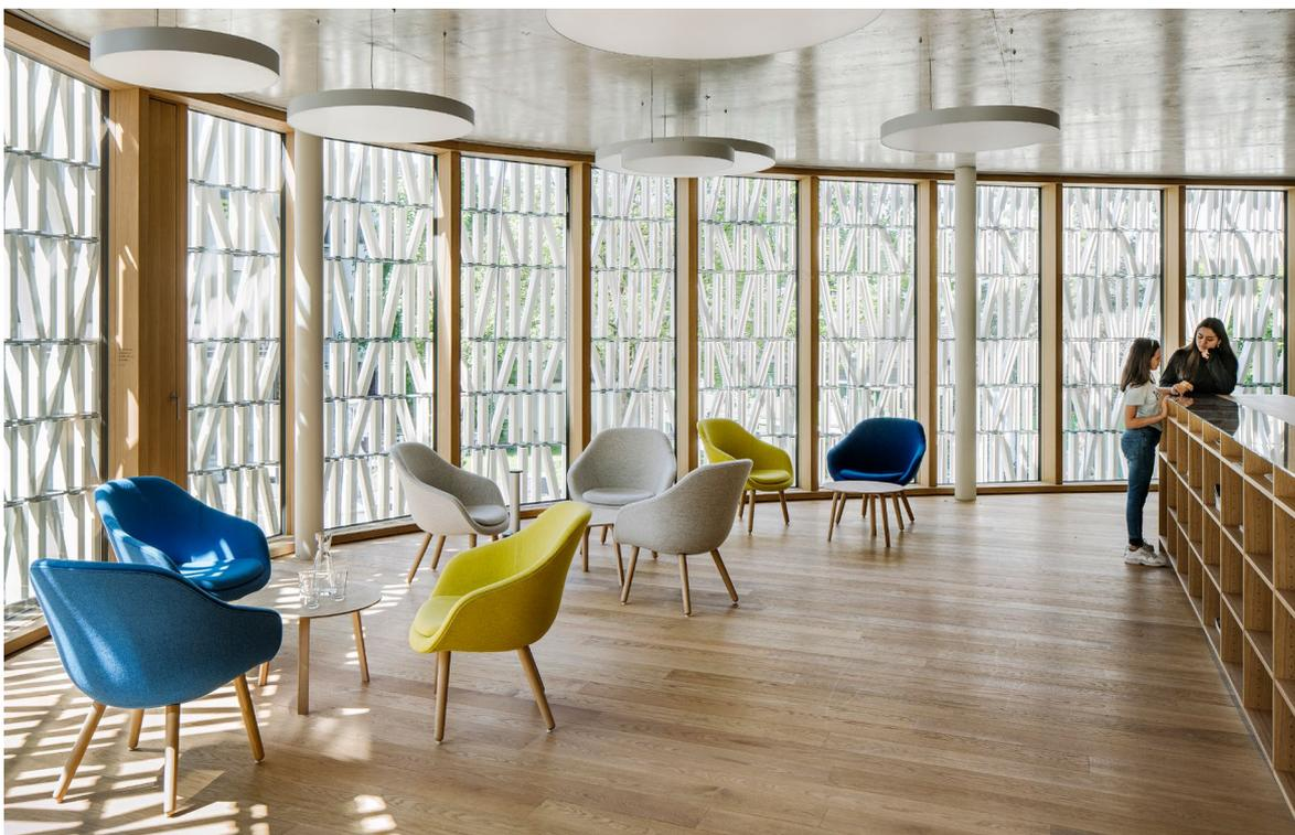
*Il padiglione ovale in vetro della Dornbirn (Austria) City Library di Dietrich | Untertrifaller è avvolto in una struttura di 8000 elementi prefabbricati in ceramica. Disposti verticalmente e inclinati, gli ornamenti di protezione solare ricordano gli scaffali delle librerie e assicurano una piacevole illuminazione degli ambienti.*
